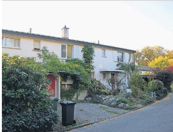
Wohneigentum soll nicht mehr subventioniert werden. An der Alderwies (im Bild eines der 16 Häuser) müssen die Eigentümer ausziehen. Foto: A. Just
