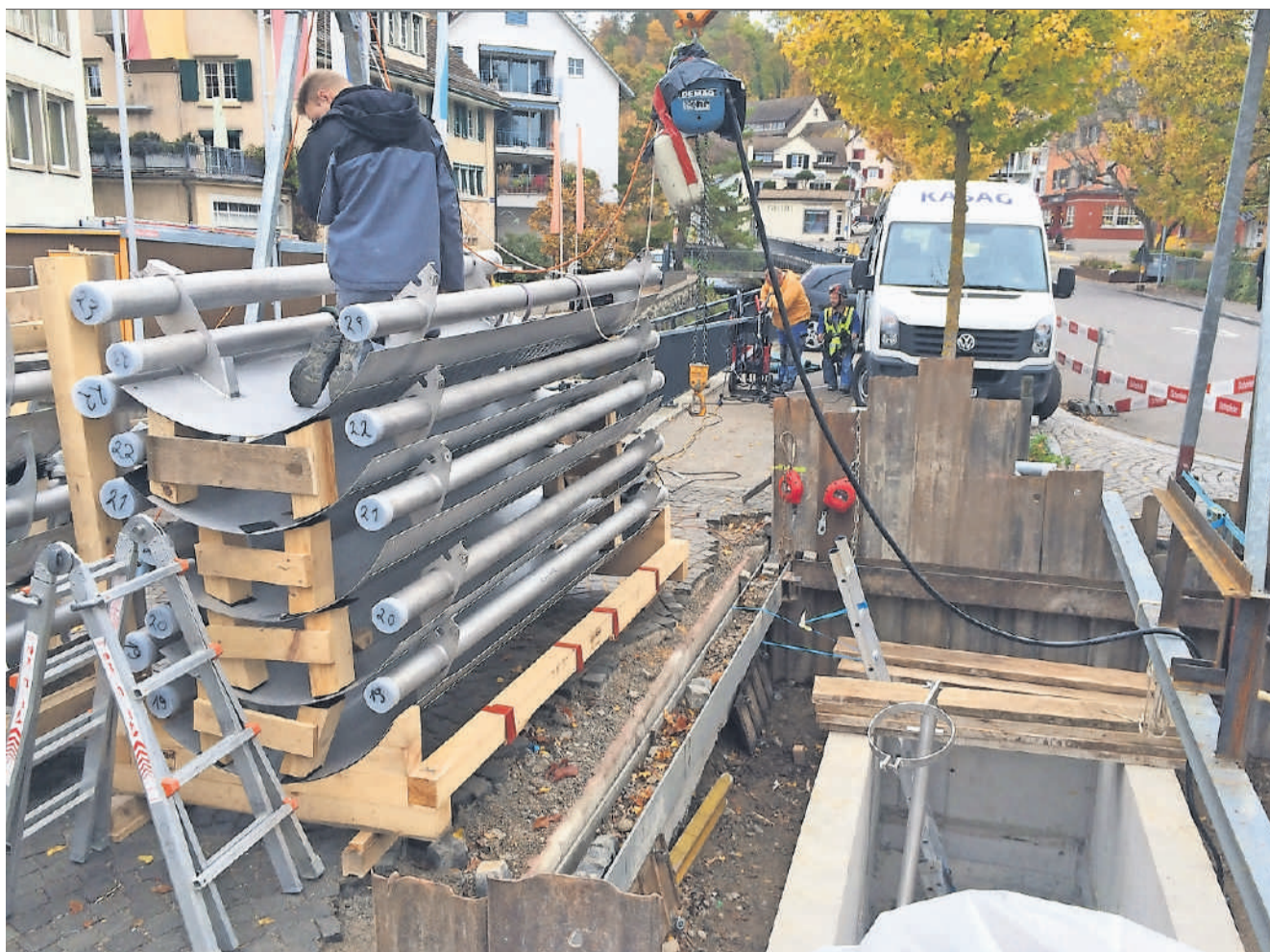
Bei der Sanierung des Dorfplatzes wurden auch die neuen Abwasserleitungen verlegt.
